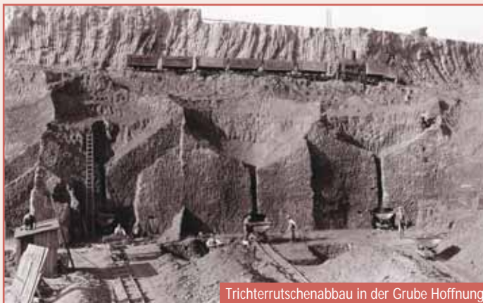
Trichterrutschenabbau in der Grube Hoffnung
